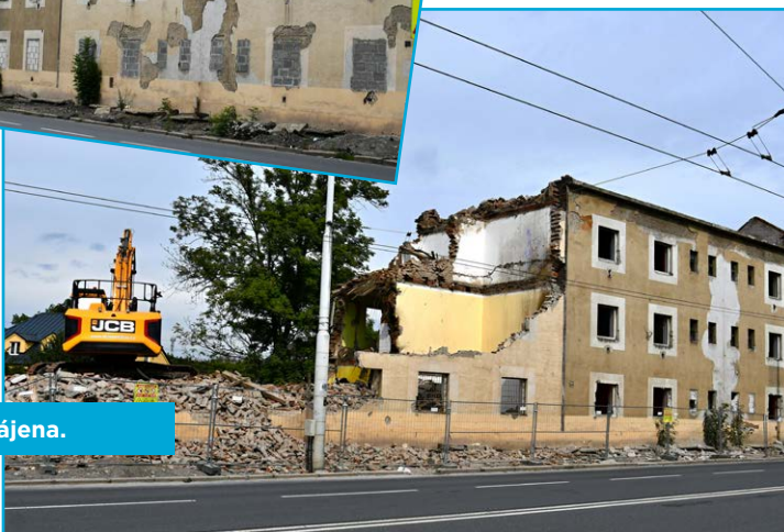
Domy před demolicí.
